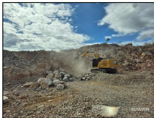
รูปที่ 2-22 การทำความสะอาดหน้างานก่อนจุดระเบิด
