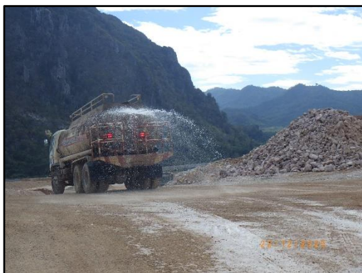
รูปที่ 2-14 การฉีดพรมน้ำบริเวณเส้นทางขนส่งแร่
